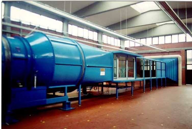
Figura 5.2 - Vista della galleria del vento del C.R.I.A.C.I.V.
